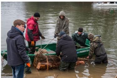
Befestigung des Totholzbündels am Motorboot
