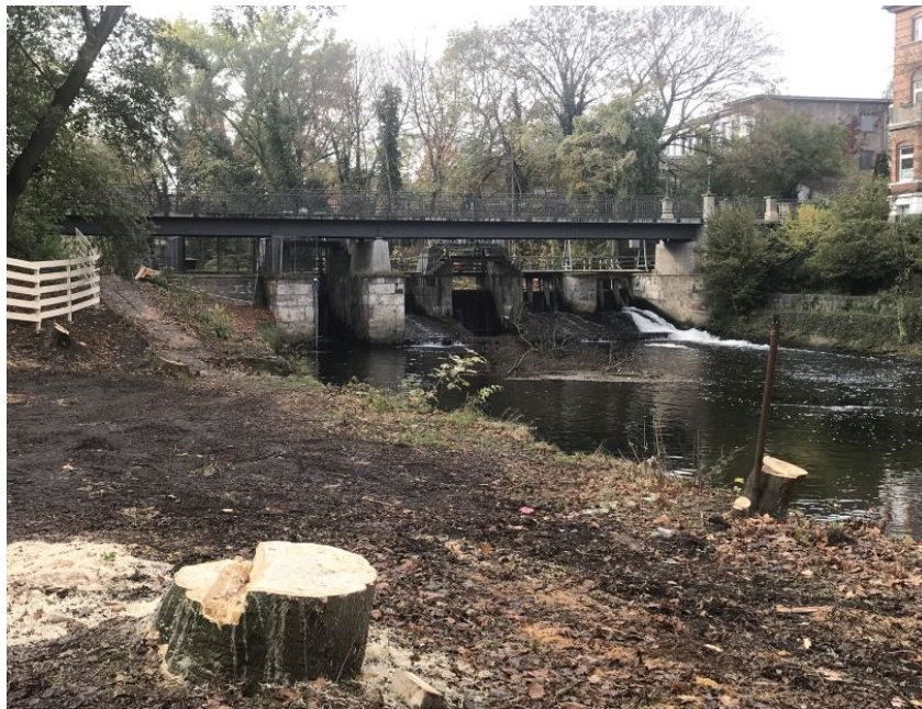
Vorarbeiten für den Baubeginn am Petriwehr in Braunschweig
