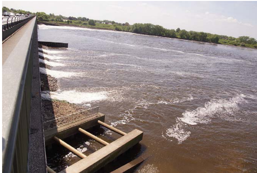
Die Lockströmungsrinnen zur Verbesserung der Auffindbarkeit des neuen Fischpasses am Nordufer, im Bild oberhalb des Fischpasseinstieges (unten), sind inzwischen ebenfalls verfüllt
