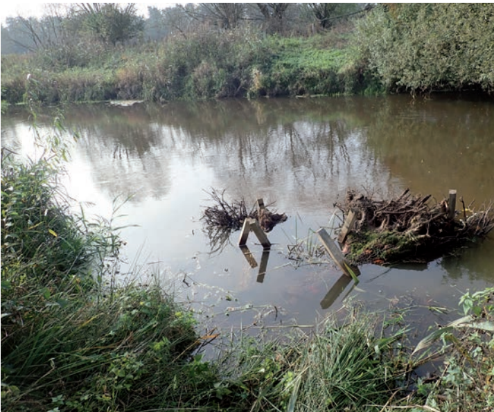
Wurzelstubben und Lenkbuhnen dienen nun als Unterstand und Strömungsschatten für die Fischfauna in der Aller.
