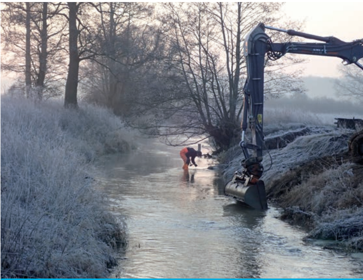
Bei Minusgraden wurde in den frühen Morgenstunden die Baumaßnahme in der Erse fertiggestellt.
