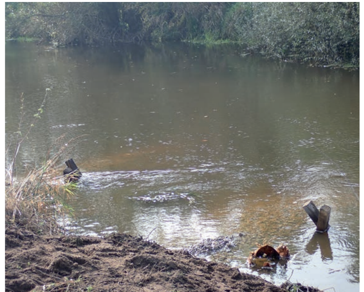
Wurzelstubben und Lenkbuhnen dienen nun als Unterstand und Strömungsschatten für die Fischfauna in der Aller.
