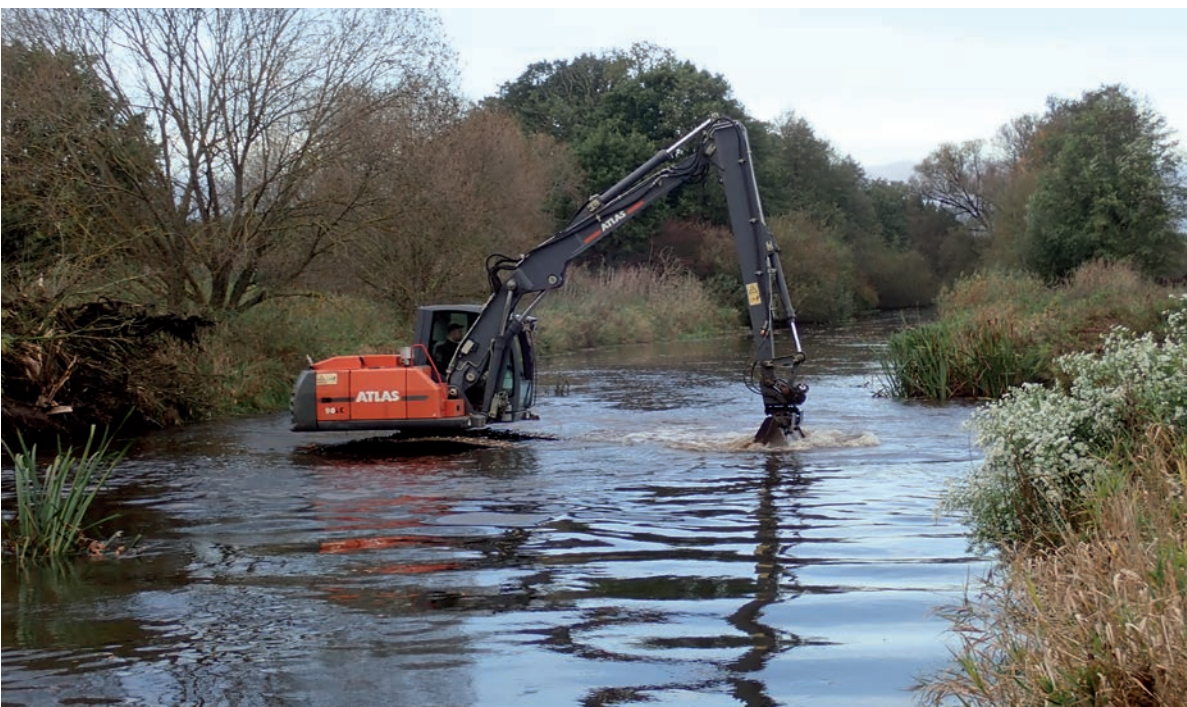
Zur Anlage der Kiesbänke musste der Bagger aufgrund der Breite der Aller ins Gewässer fahren.
