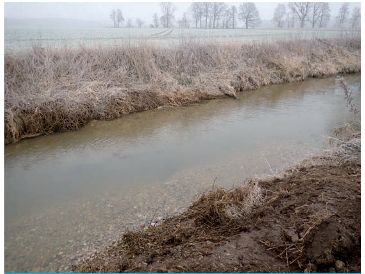
Zwei wechselseitige Kiesbänke engen nun das Gewässerprofil der Erse ein und bilden gut durchströmte Laichhabitate für die Fische.
